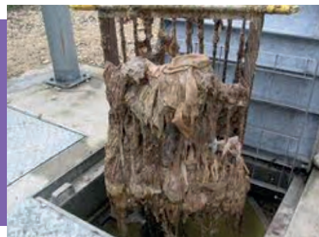
Impact des lingettes sur un dégrilleur
