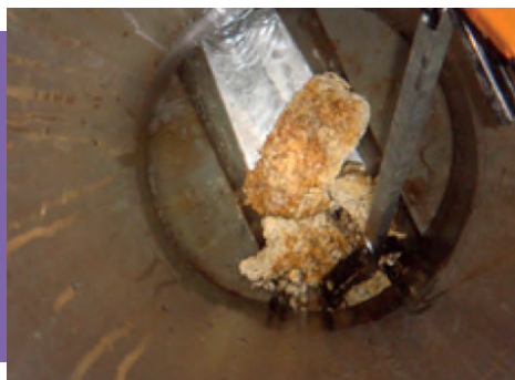
Bouchon de graisses sur le réseau d'assainissement
