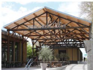
Espace patrimoine Maison de la Rivière Allier
