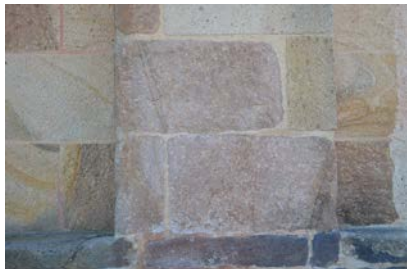
Restauration de l'église Saint-Pierre, détail
