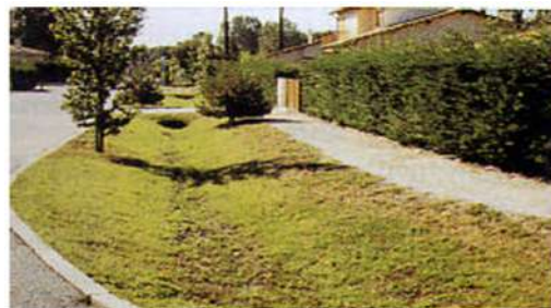
Exemples de traitement des eaux pluviales sous forme de noue ou de surfaces
