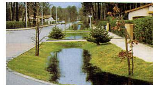
Exemples de traitement des eaux pluviales sous forme de noue ou de surfaces
