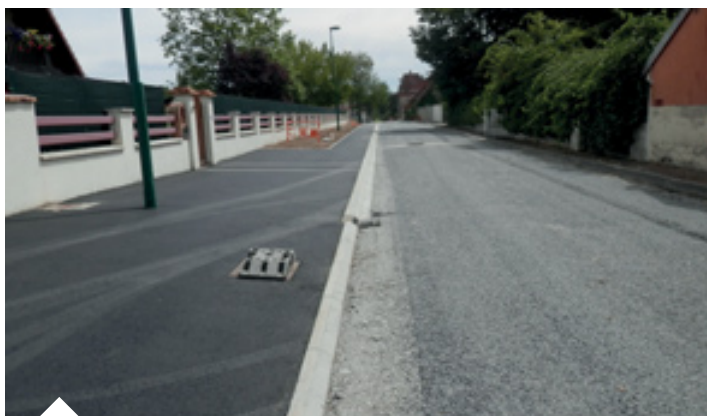
Travaux de voirie chemin de Chavennes.
