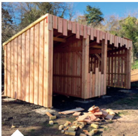
Construction par les services techniques d'une cabane pour les animaux
