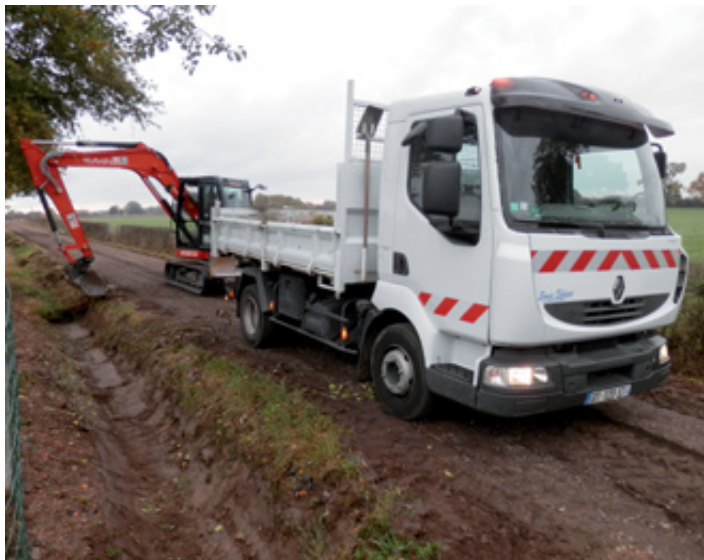
Curage des fossés et arasement d'accotement chemin des Rocs
