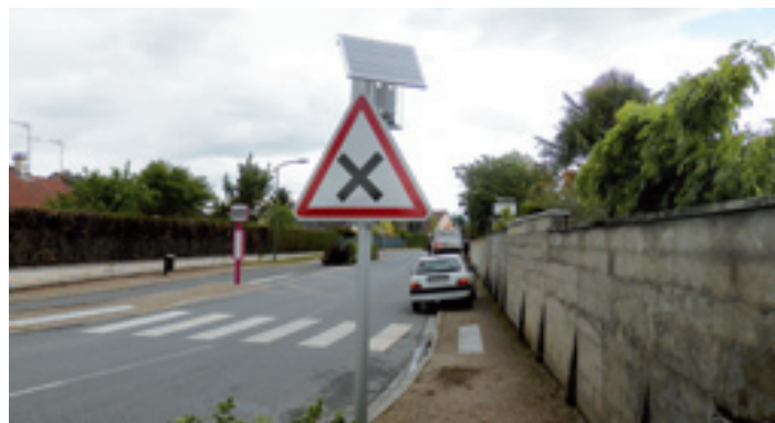
Installation de panneaux lumineux à énergie solaire avenue du 8 mai
