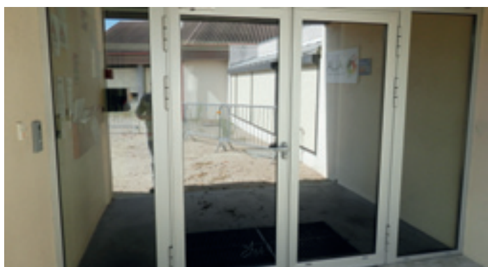
Remplacement des sas groupe scolaire Jean Moulin
