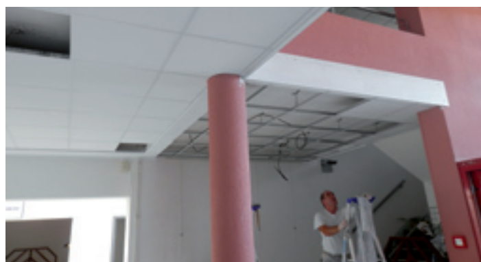
Réfection du hall d'Isléa pose d'un plafond insonorisé, peinture, électricité
