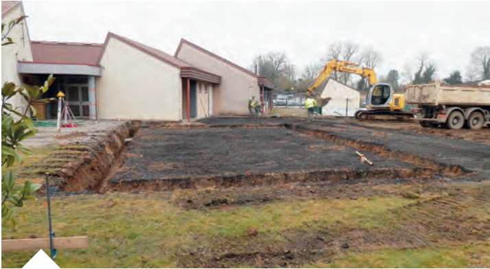
Travaux de fondation
